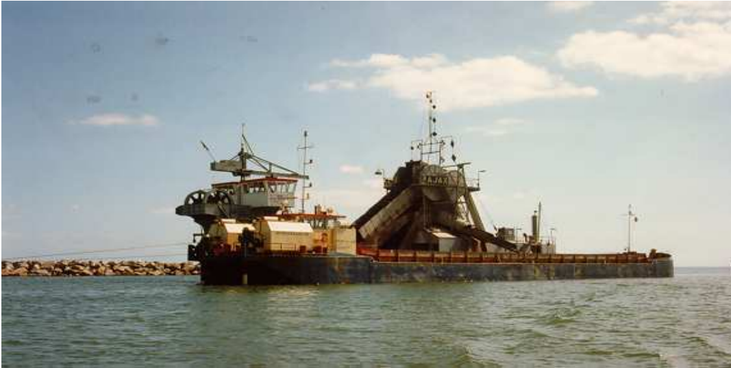
Figur 2.3: Uddybning med spandkædemaskine i Køge Havn
